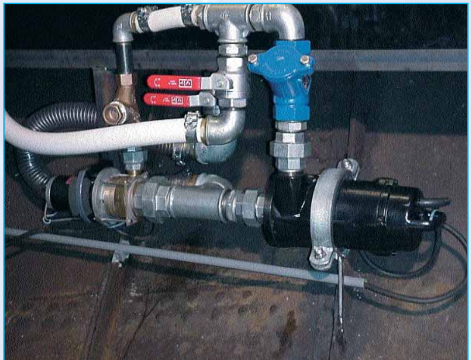
Oplossing varend woonschip. FEKA-unit met 300 liter buffertank. Hoofdpomp TP 28 (230V) in combinatie met 24 V snijdpomp.
